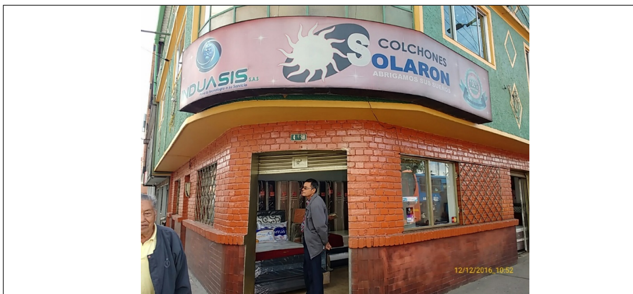
Fotografía No. 1: Vista del elemento tipo Aviso del establecimiento de comercio COLCHONES SOLARON, instalado en la Avenida Carrera 68 No. 4d – 98.
